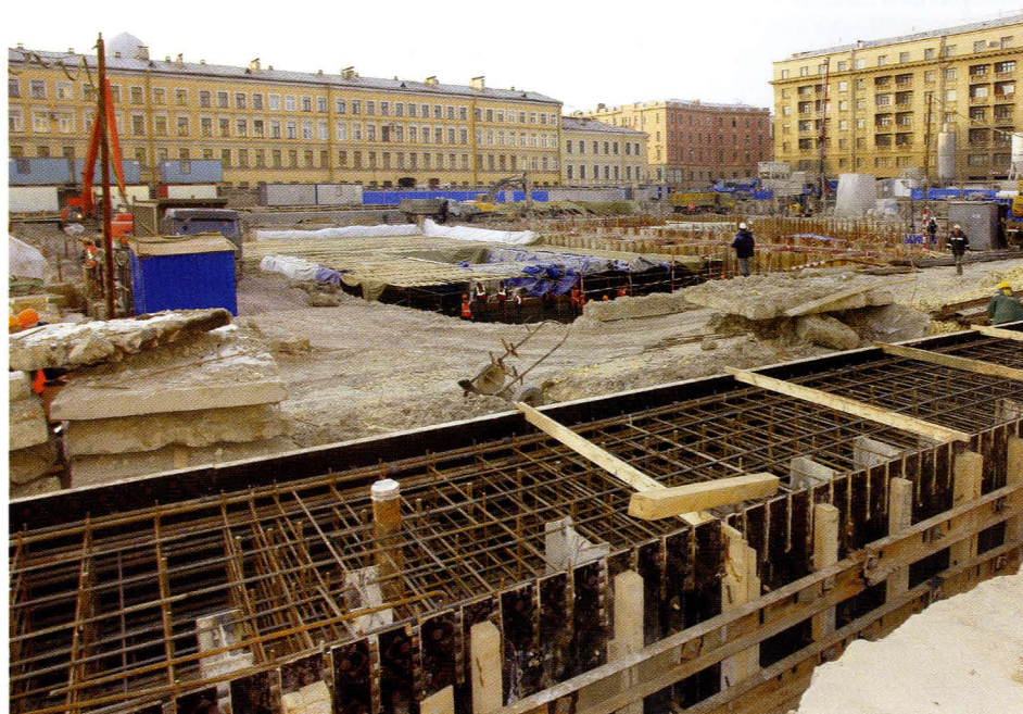
Строительство нового театра идет полным ходом
