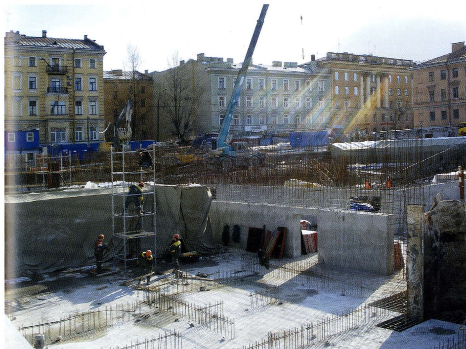
Возведение стен на отметке -4 м
