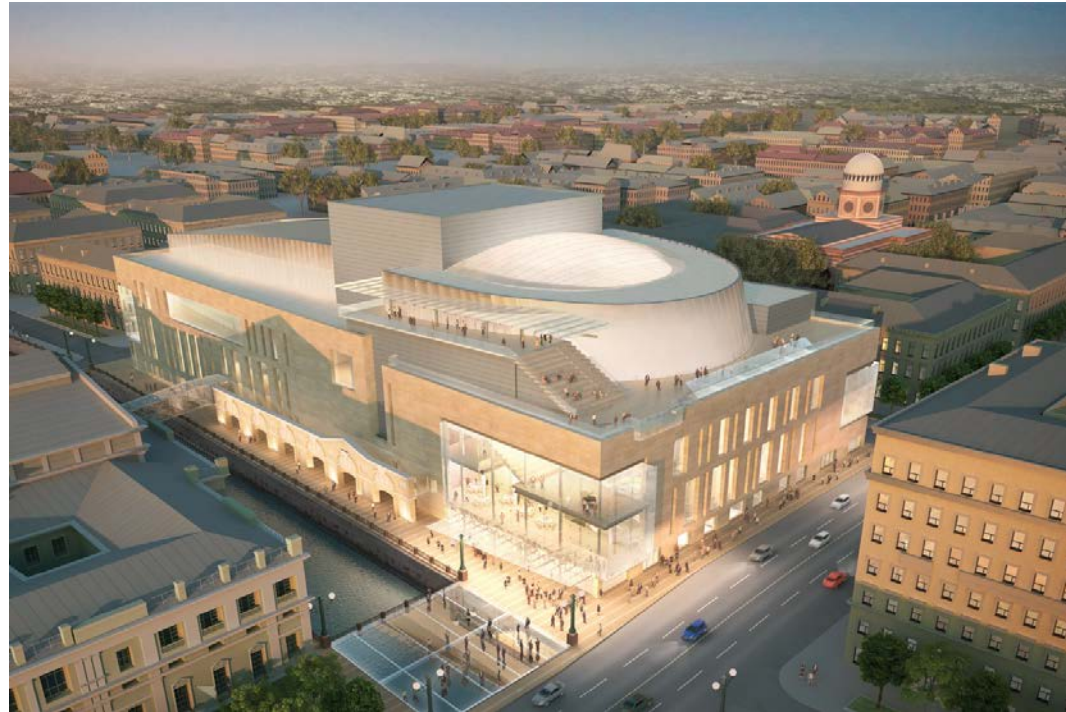
Новое здание (Вторая сцена) Государственного академического Мариинского театра. Объект введен в эксплуатацию
