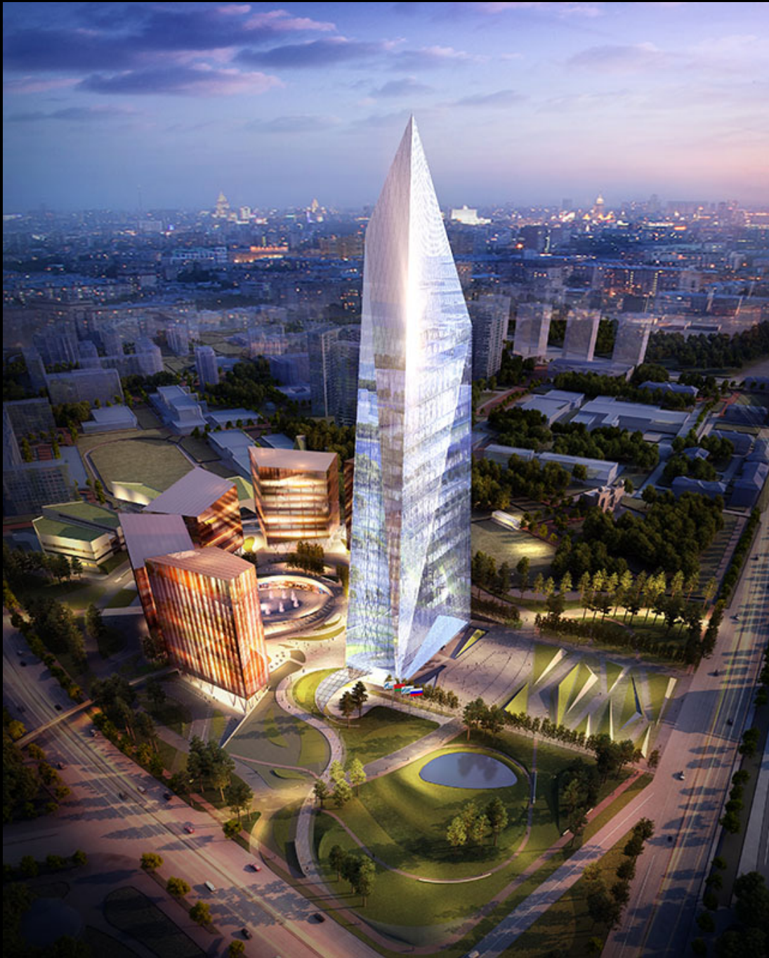
Строительство многофункционального комплекса в г. Минск
